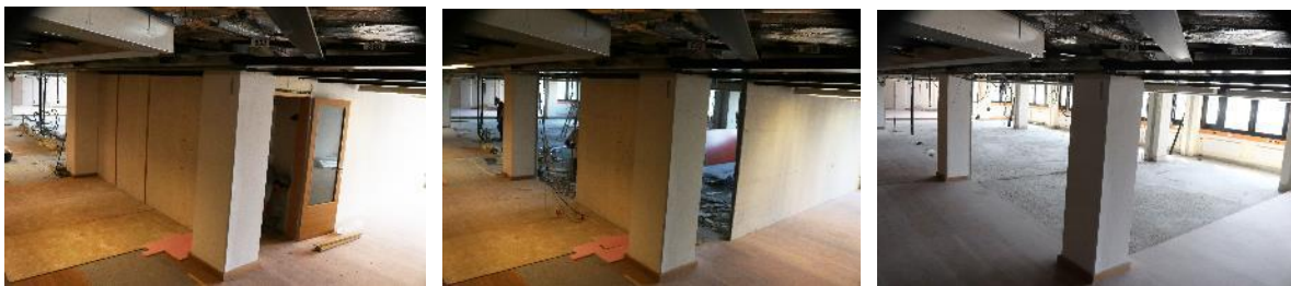
Erste Impressionen der Baustellenkamera vom Wanddurchbruch
